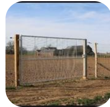
Installation de 2 portails de 6 m de largeur et 2 m de hauteur, à chaque extrémité de la centrale
